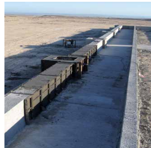
2 | Cimentación de Muros.
