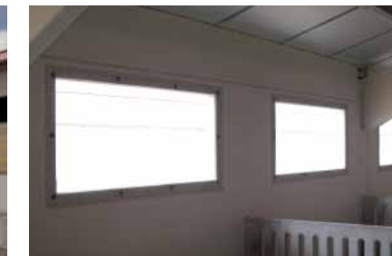
Mosquitera interior en ventanas y sujeción de separadores a cerramiento
