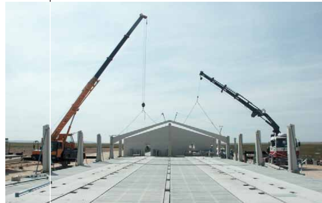
Montaje de Dinteles del Sistema Pórtico
