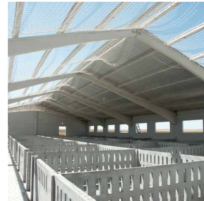
Vista desde el interior de Montaje parcial de Cubierta
