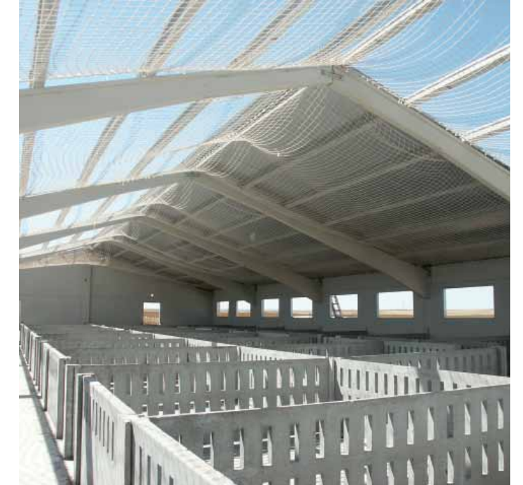
Vista desde el interior de Montaje parcial de Cubierta
