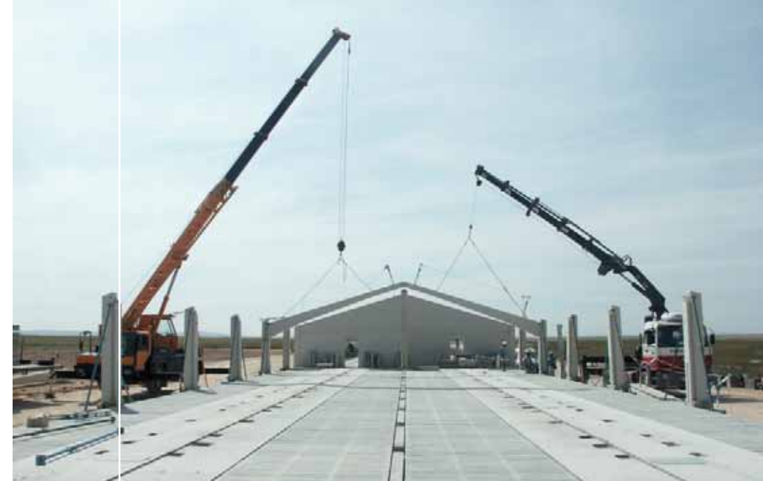
Montaje de Dinteles del Sistema Pórtico
