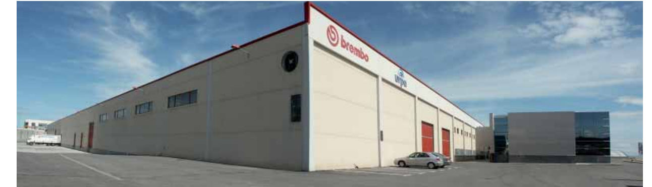
Polígono Industrial Centrovía. La Muela (Zaragoza)
