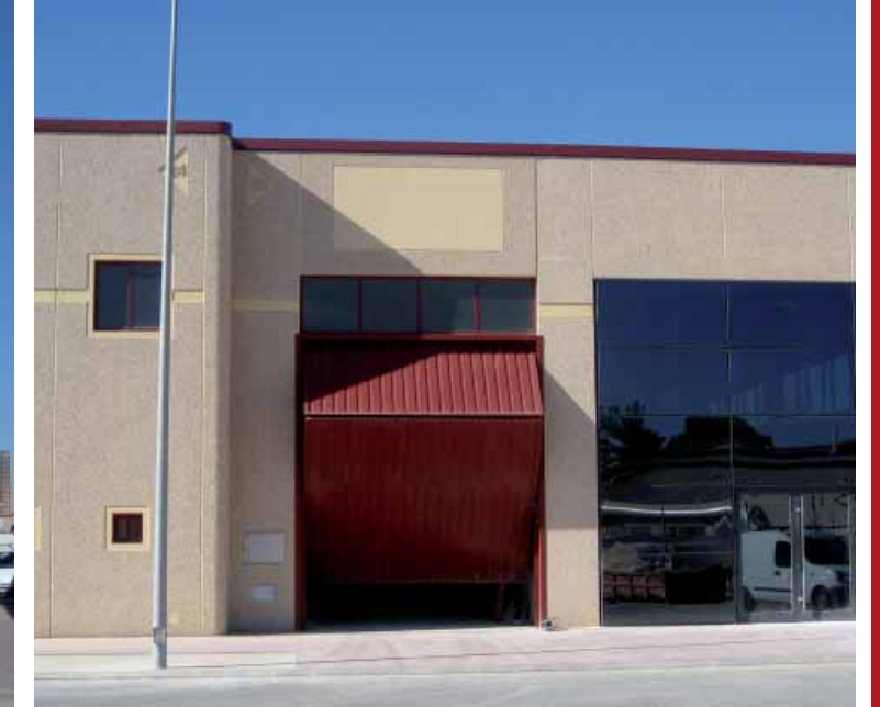
Polígono Industrial La Estación. Alcañiz (Teruel)
