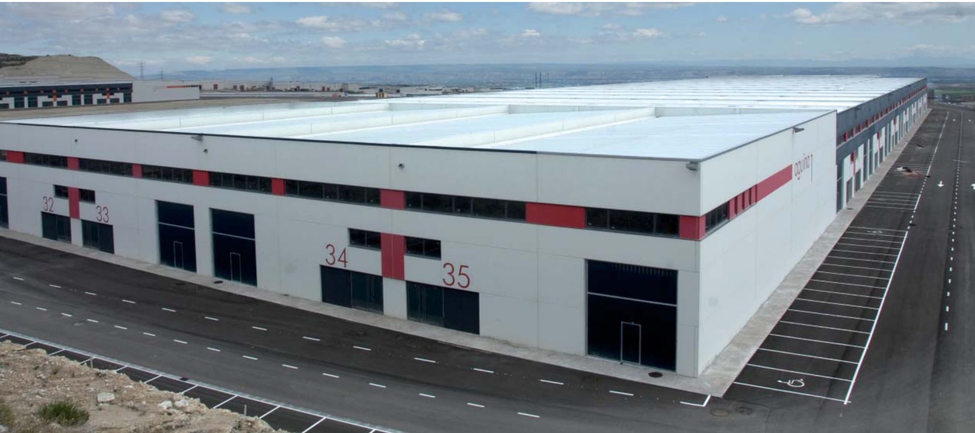
Industrial Estate Centrovía. La Muela (Zaragoza)
